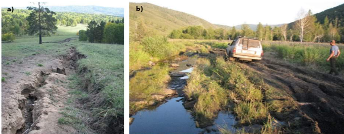
Зураг 68. Ажлын талбайн замын байдал: а) Налуугийн чиглэлээр явж буй шороон замд үүссэн хөрсний эвдрэл, ховил, Зураг 21.-г мөн үзнэ үү; б) ихэнх замаар явахад туйлын бэрхшээлтэй.
